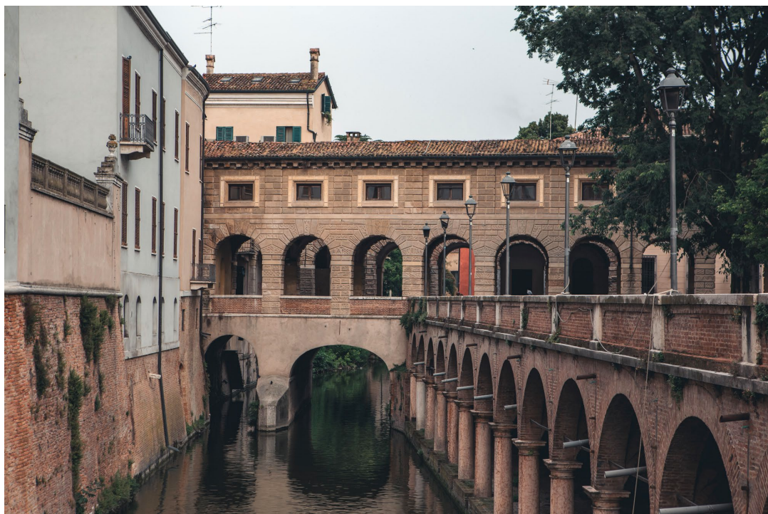
Ponte delle Pescherie di Giulio Romano
